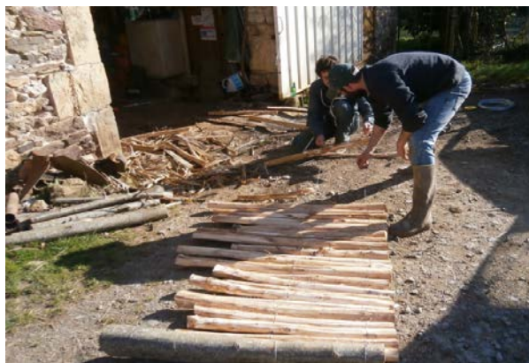
Fabrication et mise en place d'un habillage bois des buses aux entrées du bourg
