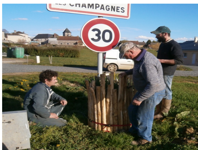
Pose des habillages
