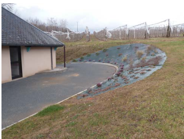
Accès handicapés salle
