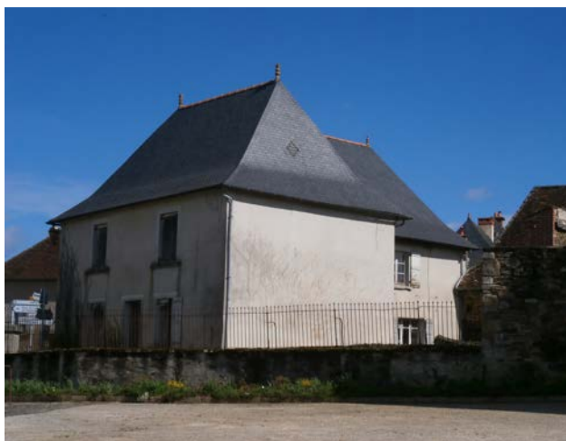
Maison Géraud avant travaux
