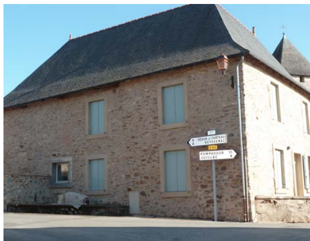
Maison Géraud en travaux
